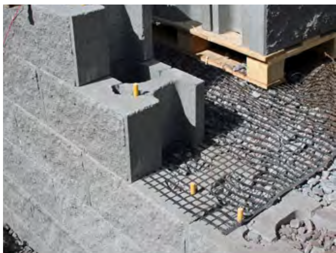
Keystone Compac med geonät.
